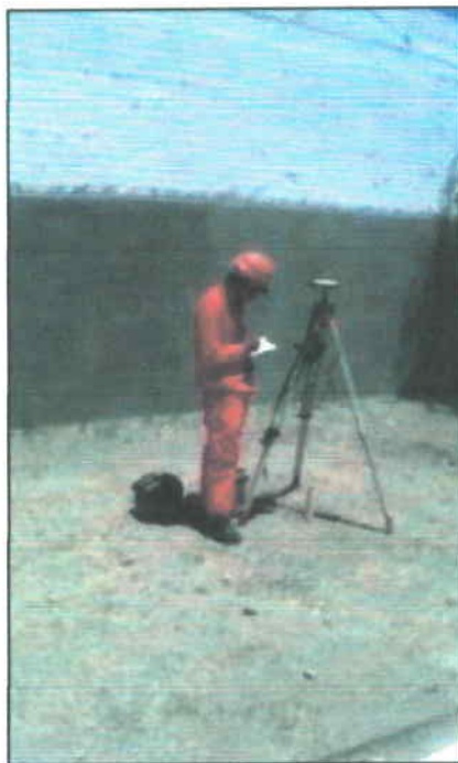
Figura 11. Medición de coordenadas y niveles con estación total.
